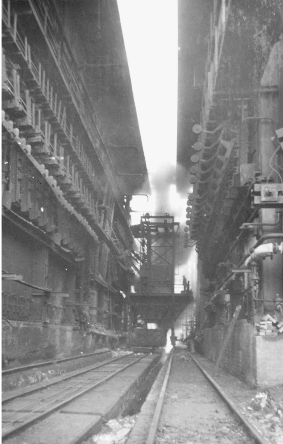
Viistokammiiouneissa kuivatislauksen seurauksena syntynyt koksi tyhjennettiin uunirakennusten välissä kulkeviin sammutusvaunuihin, jotka kuljettivat ne märkäsammustustorneihin. Kuva helmikuulta 1945. HKA
