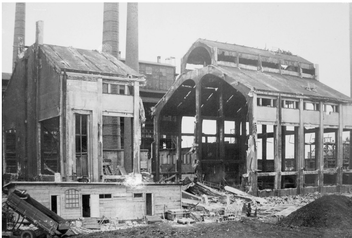
Vanhan uunirakennuksen purkutyöt meneillään elokuussa 1948. Betonitiiliseinät, uunit ja osa betonirungosta on jo poistettu. HKA
