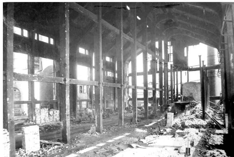
Vanhan uunirakennuksen purkutyöt meneillään elokuussa 1948. Betonitiiliseinät, uunit ja osa betonirungosta on jo poistettu. HKA
