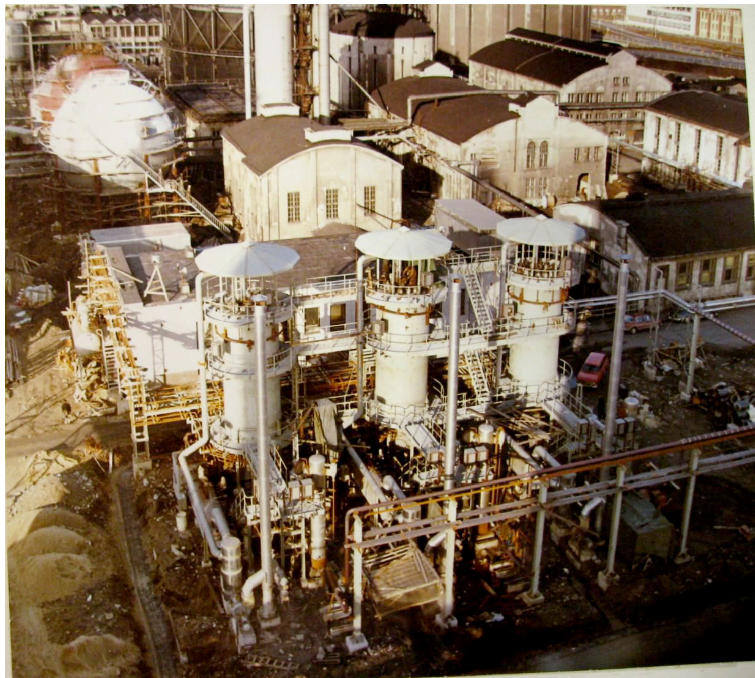
Uutta öljykaasunvalmistuslaitosta rakennetaan lokakuussa 1970. Takavasemmalla uudet butaani- eli nestekaasusäiliöt ja etualalla kaasunvalmistamo. Väliin jää valvomoksi muutettu entinen ruokalarakennus 11. Kaikki vanhat kaasulaitoksen rakennukset ovat vielä jäljellä. Muutaman vuoden kuluttua niistä oli purettu keskellä oikealla oleva vesikaasulaitos kaasusäiliöineen, sen viereinen 20-luvun kojehuone ja taustalla näkyvä rikkipesutorni sekä 20-luvun puhdistushuone. HKA
