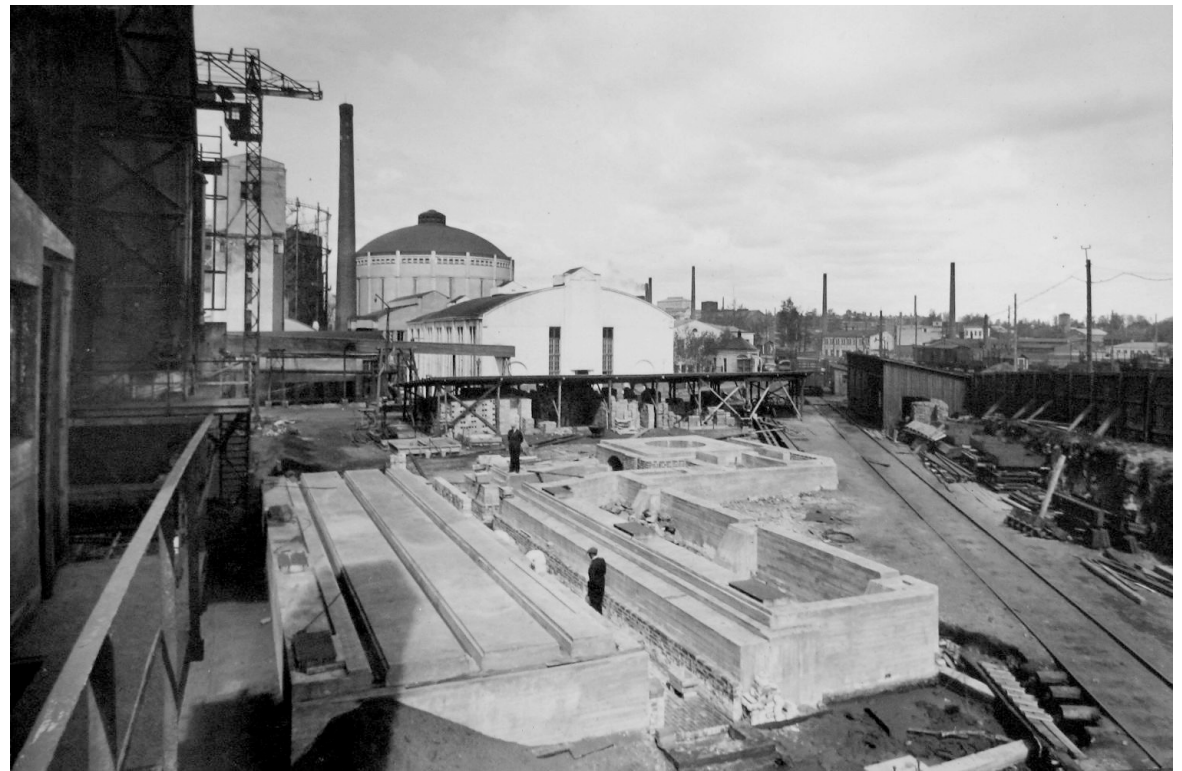
Uuden viistokammiiounirakennuksen betoniperustat toukokuussa 1941. Taustalla keskellä kojehuoneen 8 itäpäätty. HKA
