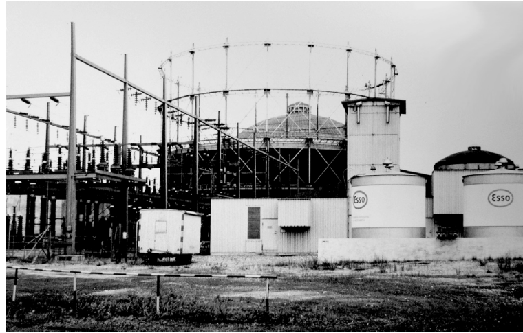
Voimala syksyllä 1975. Edessä oikealla vuonna 1957 rakennettu huolto- ja kytkinlaiterakennus Sörnäisten rantatien varrella. HKA
