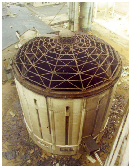
Vesikaasusäiliötä käytettiin viime ajat teräsäiliönä. Teräksiset kattorakenteet näkyvät purkutöiden edistyessä. HKA
