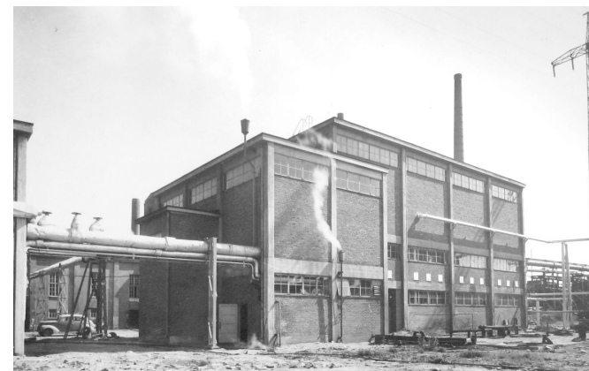
Uusi jäähdytinlaite- ja kojehuone vuonna 1953. HKA
