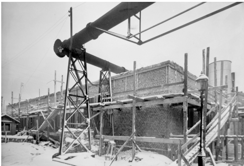
Kaasulaitoksen uutta pukuhuone- ja ruokalarakennusta rakennetaan joulukuussa 1938. Näkymä itäjulkisivusta. Huomaa kaasuväläisinpylväs ja rakennustyömaan ylittävä kaasuputki, joka johtaa taustalla häämöttävään kojehuoneeseen. HKA
