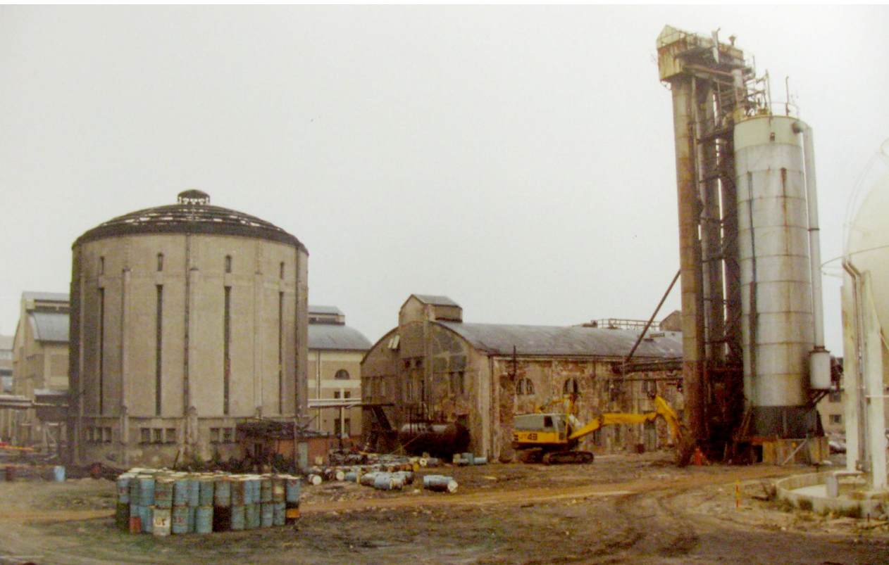
Selim A. Lindqvistin suunnittelemaa vesikaasusäiliötä sekä vesikaasu- ja ammoniakitehdasta puretaan syyskuussa 1974. Myös oikealla näkyvä rikkipesutorni purettiin samaan aikaan. HKA
