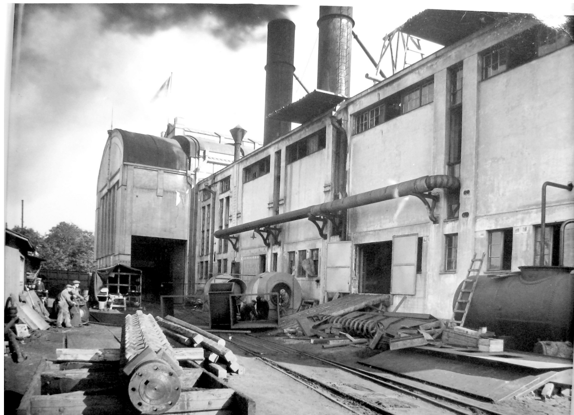
Voimalaitoksen katolla höyryävät kahden 1938 käyttöön otetun Yarrow-kattilan teräksiset savupiiput. Vasemmassa laidassa pilkkottaa puinen pukuhuonerakennus. HelEn
