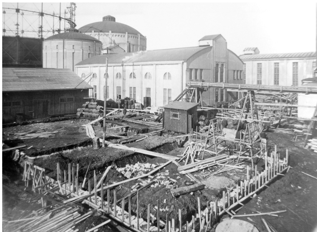
Kaasutehtaan alue etelästä laajennustöiden jälkeen 1930-luvulla. Vas. uusi kaasukello, keskellä hiilikasojen takana pilkistävät uusien koje- ja puhdistushuoneiden katot ja oik. vanhan uunirakennuksen takana viistokammariuunien korkea savupiippu. HKM Foto Roos
