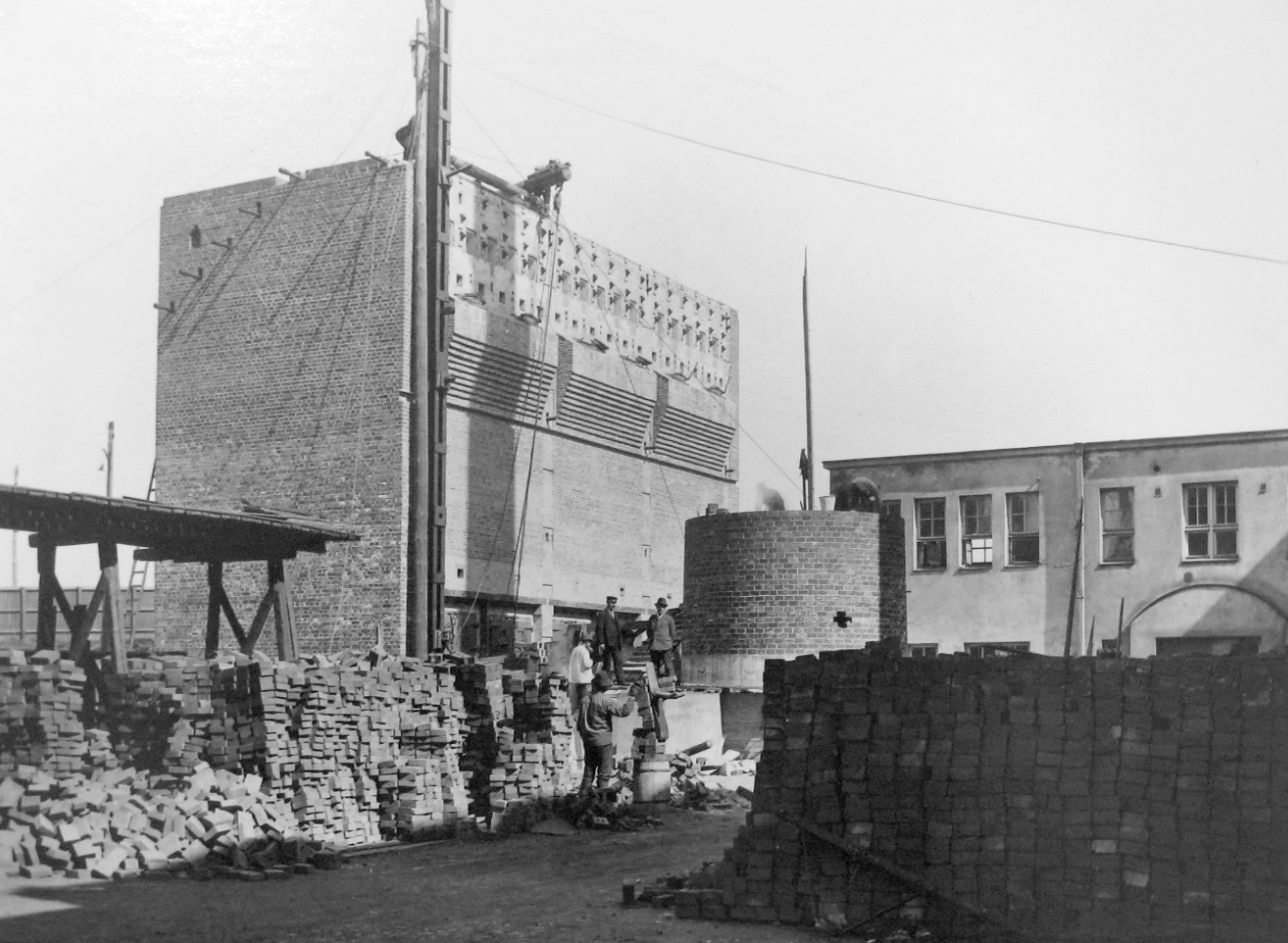
Kolme ensimmäistä viistokammiouunia savupiippuineen rakenteilla toukokuussa 1928. Taustalla vanhan uunihuoneen henkilökuntarakennus. HKA
