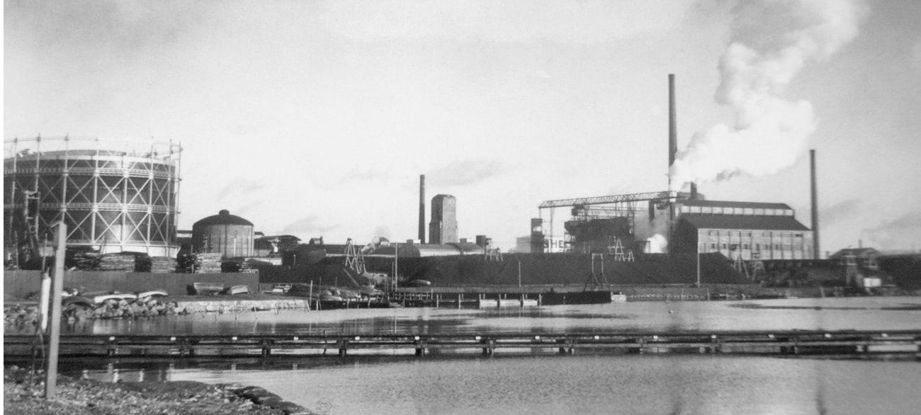
Kaasutehtaan alue etelästä laajennustöiden jälkeen 1930-luvulla. Vas. uusi kaasukello, keskellä hiilikasojen takana pilkistävät uusien koje- ja puhdistushuoneiden katot ja oik. vanhan uunirakennuksen takana viistokammariuunien korkea savupiippu. HKM Foto Roos
