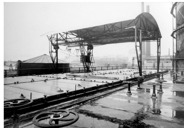
Uuden puhdistushuoneen massarkut olivat taivasalla ja puhdistusmassa vaihdettiin rakennuksen päällä kulkevalla nosturilla. Tammi 1930. HKA
