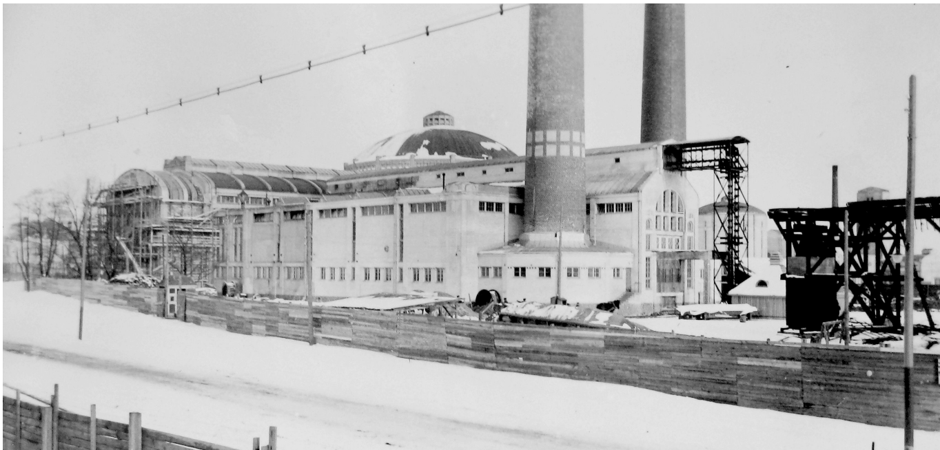
Laajennuksen hiilisuppiloiden valumuotteja tehdään heinäkuussa 1913 (yllä). HelEn
