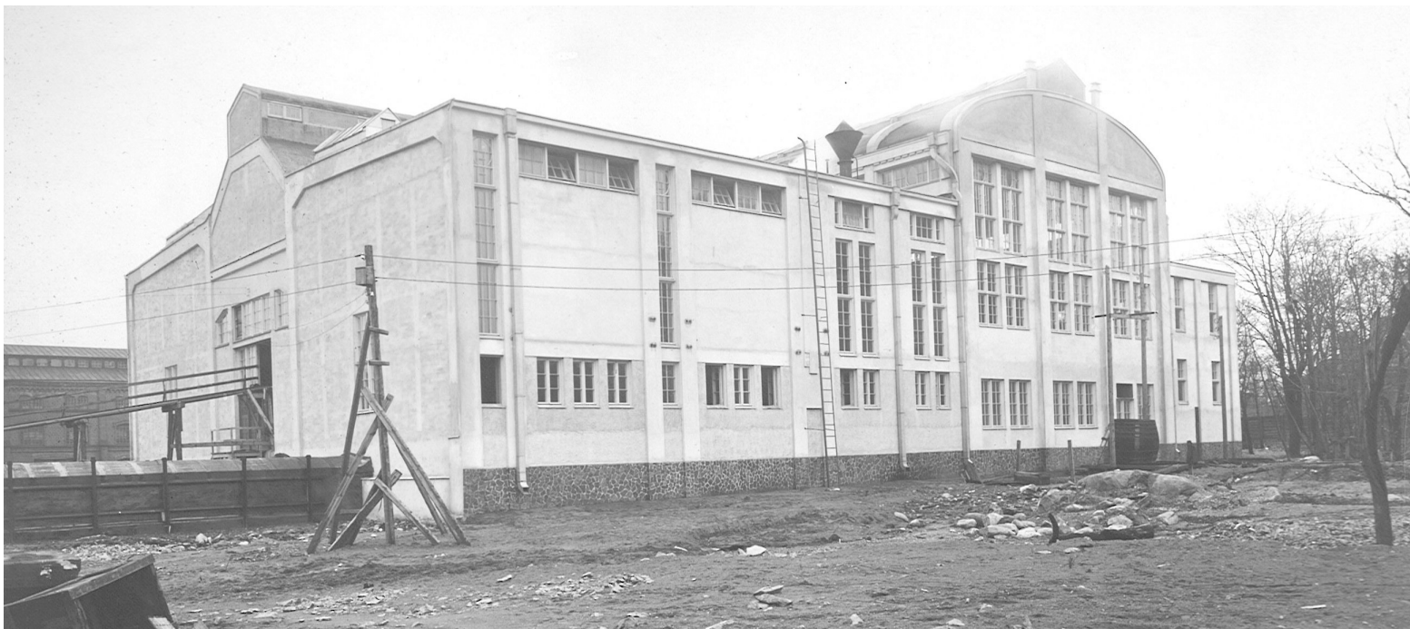
Suvilahden sähkövoimalaitos kaakosta päin vuonna 1909. Vasemmalla kattilahalli ”klerestoriokerroksineen” ja sen jatkona pumppulaitteiden tilat, sitten kaarevakattoinen turbiinisali ja sen takana pohjoispään valvomo- ja kytkinlaitetilat. Eteläjulkisivu rakennettiin väliaikaiseksi täyttämällä betonirakenteiden välit punatiilillä, koska ne oli muissa seinissä käytettyjä sementtitiiliä helpompi purkaa. Kivihielet kuljetettiin höyrykattiloihin aluksi vasemmalla näkyvää puuluiskaa pitkin. Kattiloiden savukanava kulki taivasalla savupiippuun, joka jää vasemalle kuvan ulkopuolelle. HelEn
