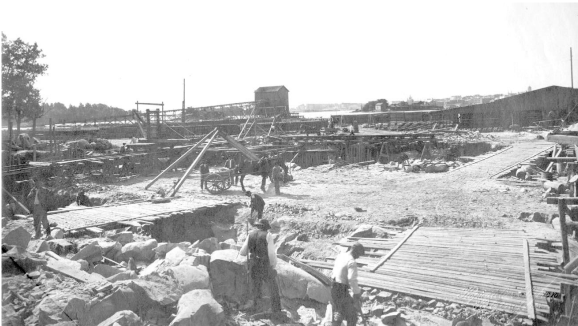
Sähkövoimalan perustuskuoppia kaivetaan 1908. HelEn
