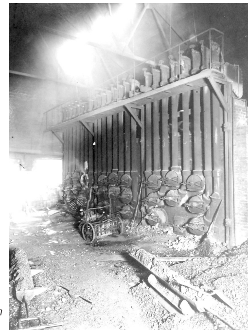
Pystyretorttiuuni Heikinkadun kaasulaitoksella. HKA
