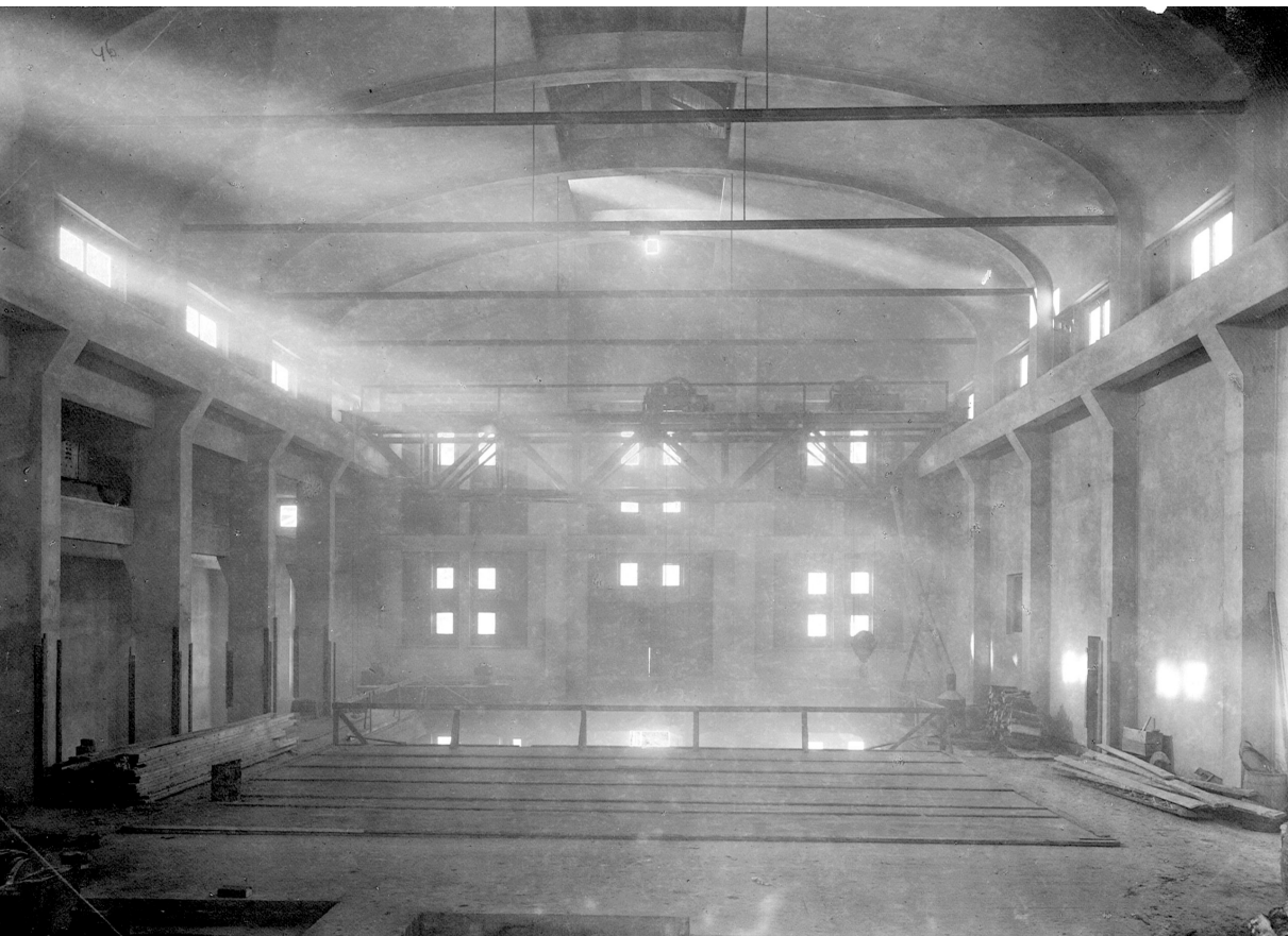
Tuleva turbiinihalli betonivalu- töiden valmistuttua. HelEn
